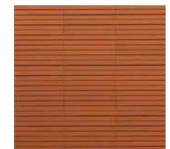
Тонкий шов вровень с поверхностью
